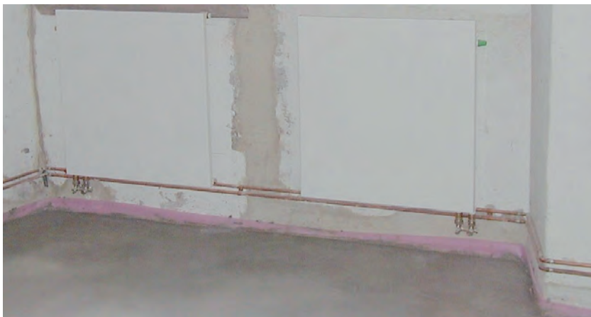
Abb. 10. Strahlplatten und offen verlegte, ungehindert abstrahlende Heizrohre (Bauzustand) – eine substanzschonende, aber auch energie- und kostensparende Variante der Strahlungsheizung.
