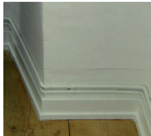
Abb. 10. Strahlplatten und offen verlegte, ungehindert abstrahlende Heizrohre (Bauzustand) – eine substanzschonende, aber auch energie- und kostensparende Variante der Strahlungsheizung.
