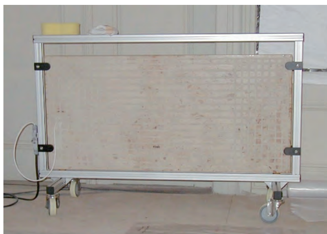
Abb. 13. Elektrische Direktheizungen wie die Marmorplattenheizkörper (Abbildung zeigt Rückseite) sind gut regelbar, geeignet für hochwertig ausgestattete Räume, die aus Havarieschutzgründen nicht mit wasserführenden Heizsystemen ausgestattet werden sollen und auch mobil für nur zeitweisen Bedarf einsetzbar. Es gibt auch Systeme aus Glas und anderen Werkstoffen, die fallweise erhebliche Gestaltungsspielräume für den Einsatz in historischen Räumen zulassen.
