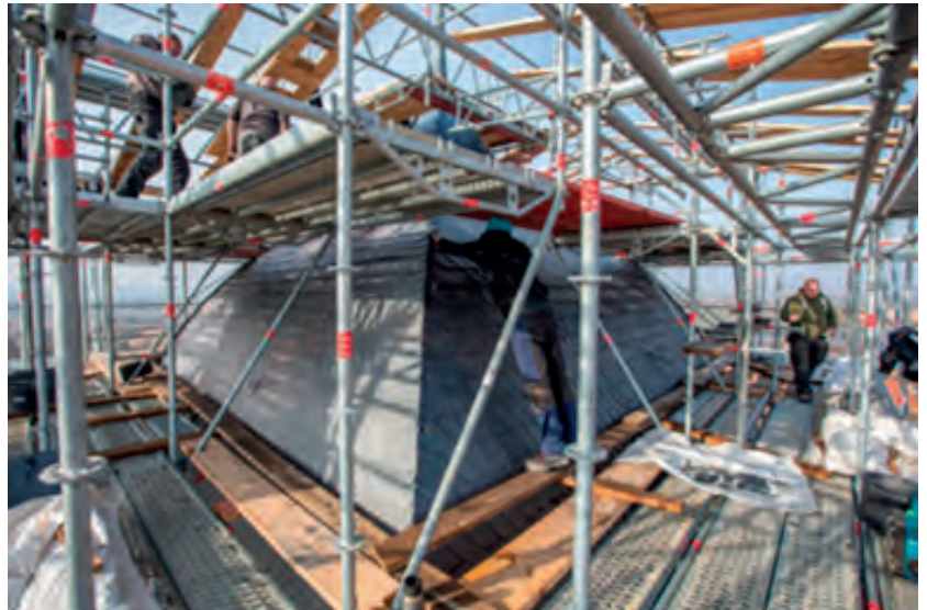
Abb. 8. Handwerker bei der Arbeit: Weißensee, Runneburg, Turmhaube Palasturm: Schieferarbeiten (Foto: Stiftung Thüringer Schlösser und Gärten, Tino Trautmann).
