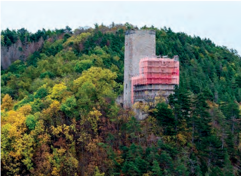
Abb. 6. Baustelle: Burg- ruine Ehrenstein mit Gerüst (Foto: Philipp Hort).
