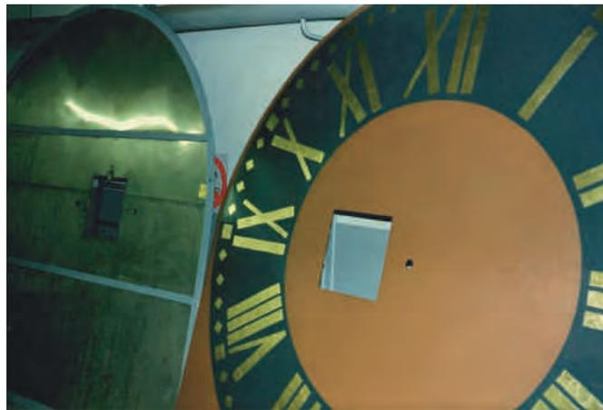
Abb. 64. Zifferblätter einer Kirchturmuhre aus Edelstahlblech: Rückseite farblos aktiv passiviert, vorderseitige Farbgestaltung mit der Wiederholung der Farben des Turms und des Daches, also schiefergrau sowie Mischfarbton aus gelbem und rotem Sandstein.
