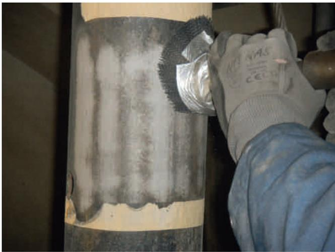
Abb. 29. Während der staubfreien Strahlentrostung an einem Fahnenmast zur Abnahme von Rost und Altkonservierungen mit schwermetallhaltigen Pigmenten.
