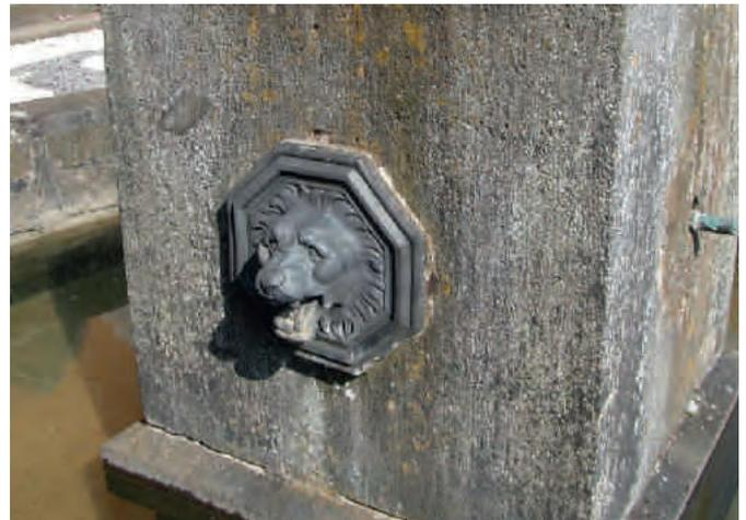
Abb. 45. Wasserspeiender Löwenkopf aus Bleiguss, mehrfach farbig überstrichen ...
