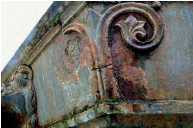
Abb. 33. Ausgangszustand: durchrostete Altanstriche und partielle Materialzerstörungen (Rissbildungen) sowie stellenweise Materialverluste (Abbrüche).
