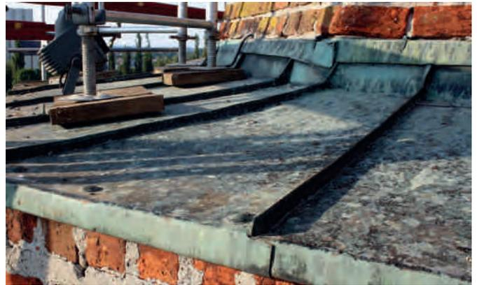
Abb. 49. Auf horizontal befestigten Kupferblechbedeckungen verbleibende Verschmutzungen sollten bei Fassadenreinigungen abgenommen werden (Foto: J. Holst).
