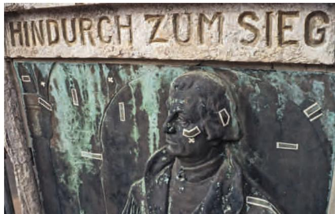
Abb. 51. Befundung an einer Bronzerelieftafel zur Bestimmung der lokal vorliegenden Schichtensituation, deren Ergebnisse zur Erarbeitung des Restaurierungskonzepts herangezogen werden; im weiteren Verlauf dienen die markierten Stellen als Musterflächen für Reinigungs- bzw. Freilegungsarbeiten mit dem Ziel, artfremde Schichten abzunehmen und arteigene (braune Oxidpatina und feste grüne Naturpatina) zu erhalten.
