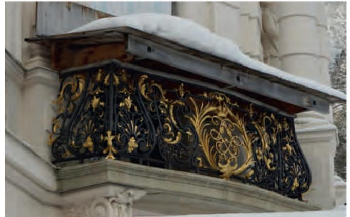
Abb. 2. Abdeckung eines Balkons mit teilvergoldetem schmiedeeisernem Ziergitter als winterlicher Witterschutz.
