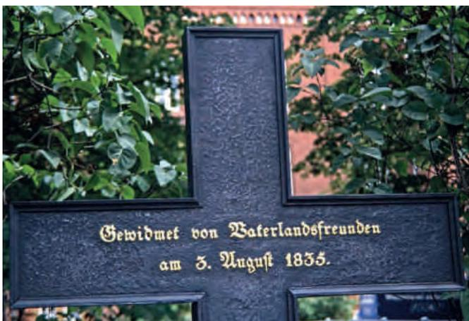
Abb. 1. An einem gusseisernen Kreuz sind nach farbiger Neukonservierung und erhabener Schriftvergoldung typische Oberflächenmerkmale der Alterung im Freien erhalten und erkennbar geblieben.
