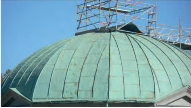
Abb. 15. Dacheindeckung mit gefalzten Kupfertafeln und vollständig ausgebildeter Naturpatina.
