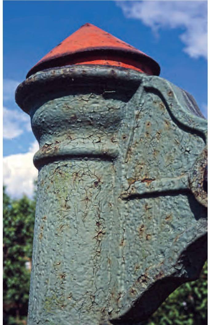
Abb. 7. Wasserpumpensäule mit Rissbildung und partieller Durchrostung in den Altanstrichen, die insgesamt keine Schutzfunktion mehr erfüllen; damit auch Verlust des dekorativen Erscheinungsbildes.
