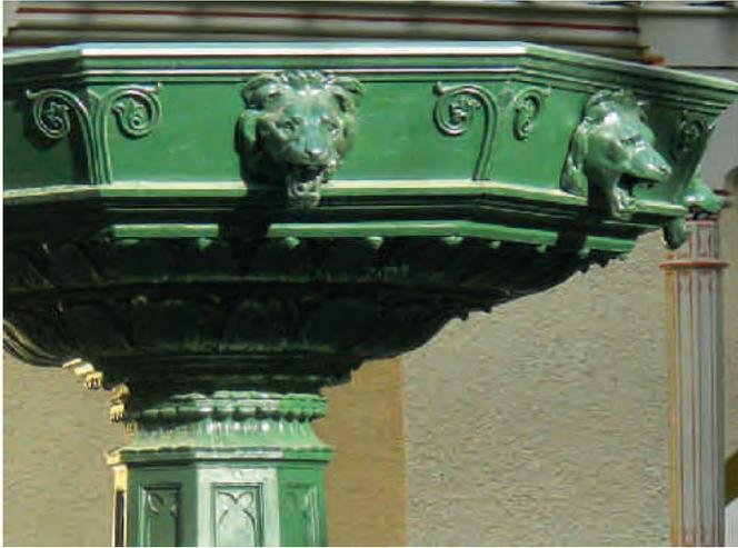
Abb. 32. Endzustand der Restaurierung: Wiederherstellung der originalgerechten Farbgestaltung (nach Farbbefund) mit vier Anstrichen.
