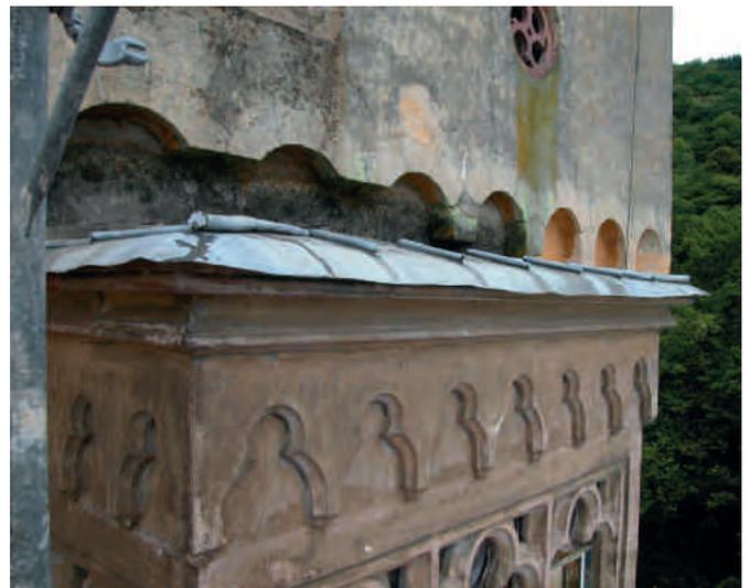
*Abb. 10. Abdeckung aus verlöteten Zinnblechstreifen auf einem Erker.*
