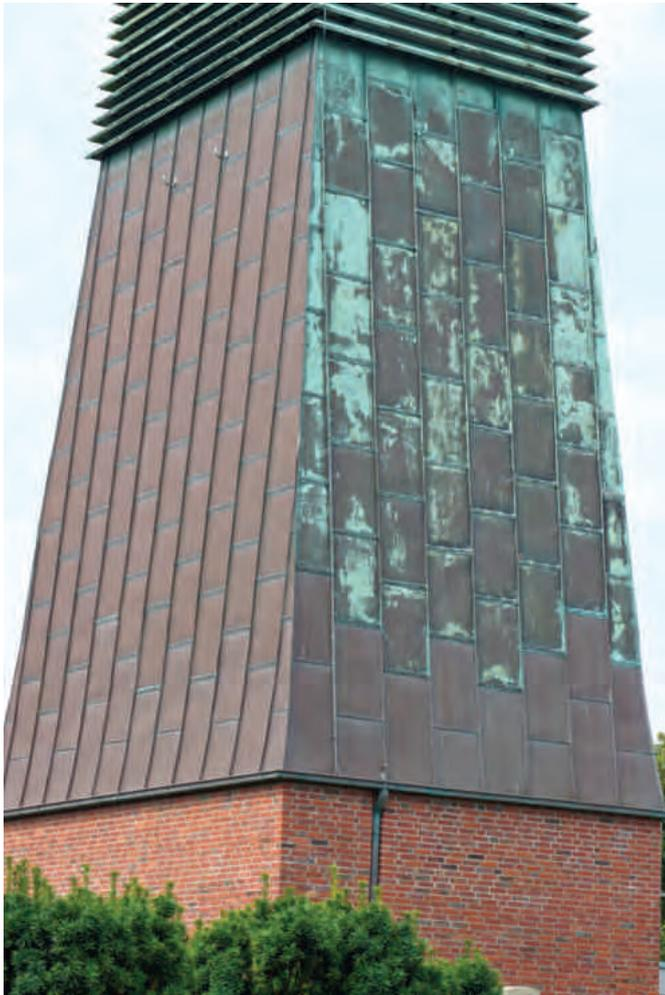
Abb. 47. Rekonstruktion/Ersatz historischer gefalzter Kupferblechdächer mit neuem Kupferblech, auf der Wetterseite beginnt die Mineralisierung.
