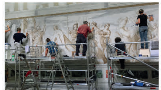
Dresden, Großer Schlosshof. Wiederherstellung der Renaissancefassaden (Foto: S. Posselt).
