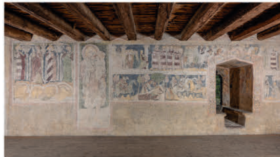
Siedlęcín (Boberröhrsdorf), Wohnturm. Fragment der Wandmalereien an der Südwand des Großen Saals im zweiten Obergeschoss (Foto: J. Śliwa).
