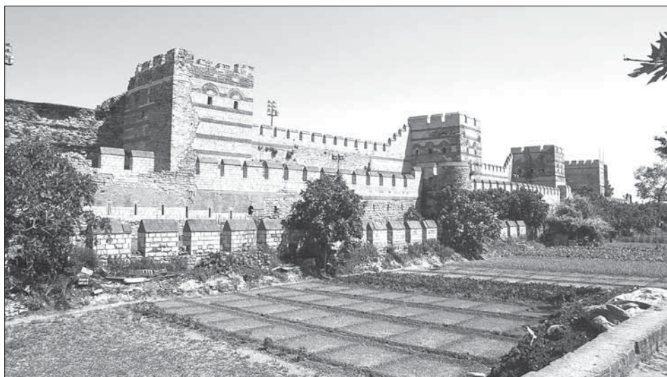
Obr. 7. Konstantinopolis (Istanbul), Theodosiánské hradby. Nahoře: oktogonální věž hlavní hradby. Dole: čtverhranné věže hlavní hradby v nevhodné (naštěstí zastavené) památkové úpravě. Foto autor.
